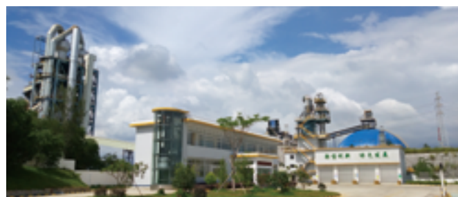
位于广州的珠江水泥干化污泥协同处置项目建成投入运营
